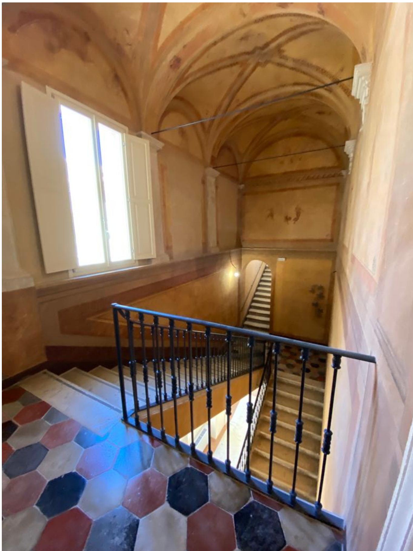
L'AQUILA - Lunedì 6 giugno alle ore 11 la Fondazione Carispaq presenta il restauro di Palazzo Alferi De Torres in Piazza Santa Giusta a L'Aquila, di proprietà della Fondazione stessa.
