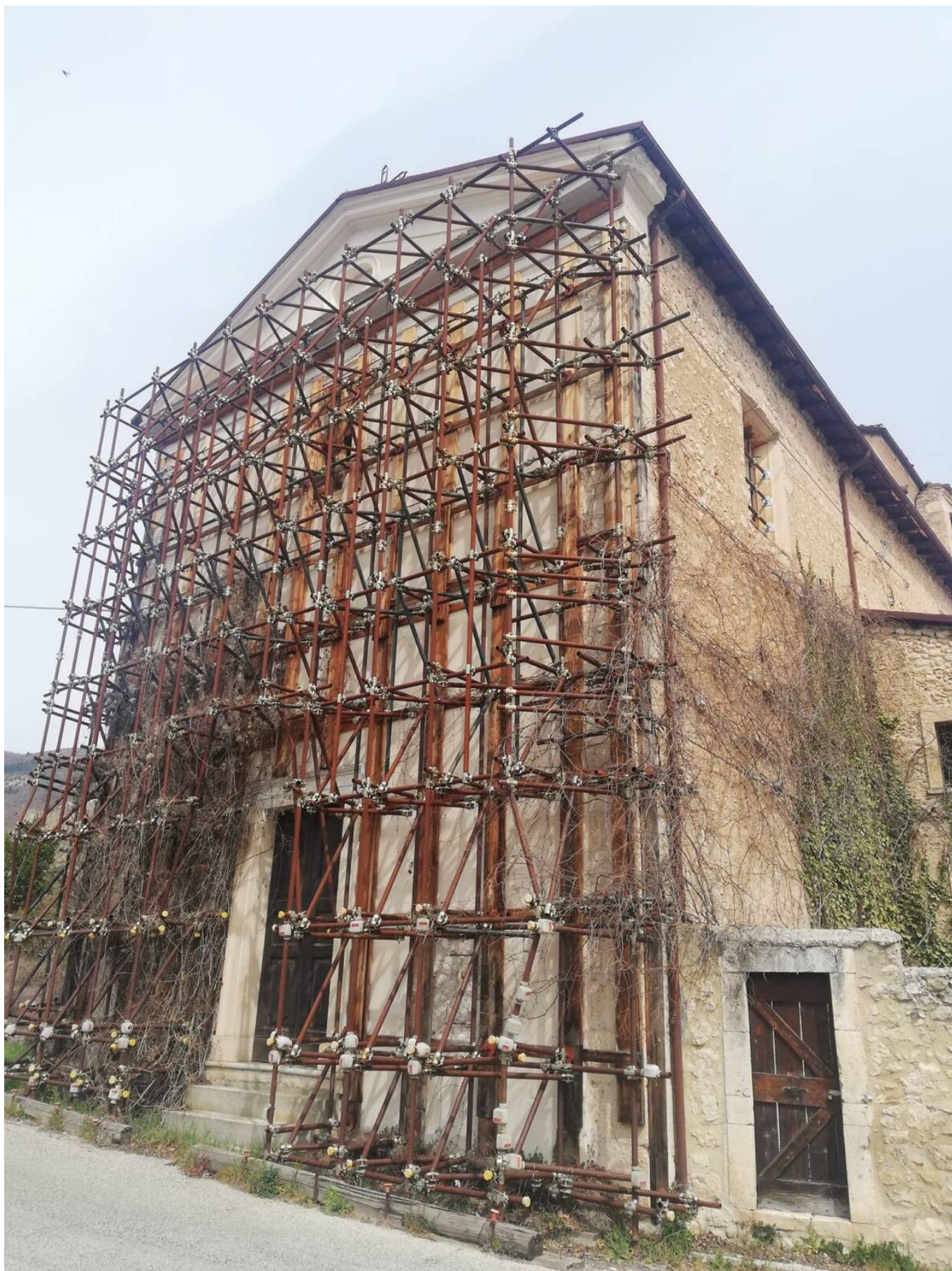
L'AQUILA - Sono stati consegnati ieri i lavori per il restauro conservativo e miglioramento sismico della chiesa di Santa Maria delle Grazie sita nella frazione di Santa Maria del Ponte nel comune di Tione degli Abruzzi, danneggiata dal sisma del 2009.
