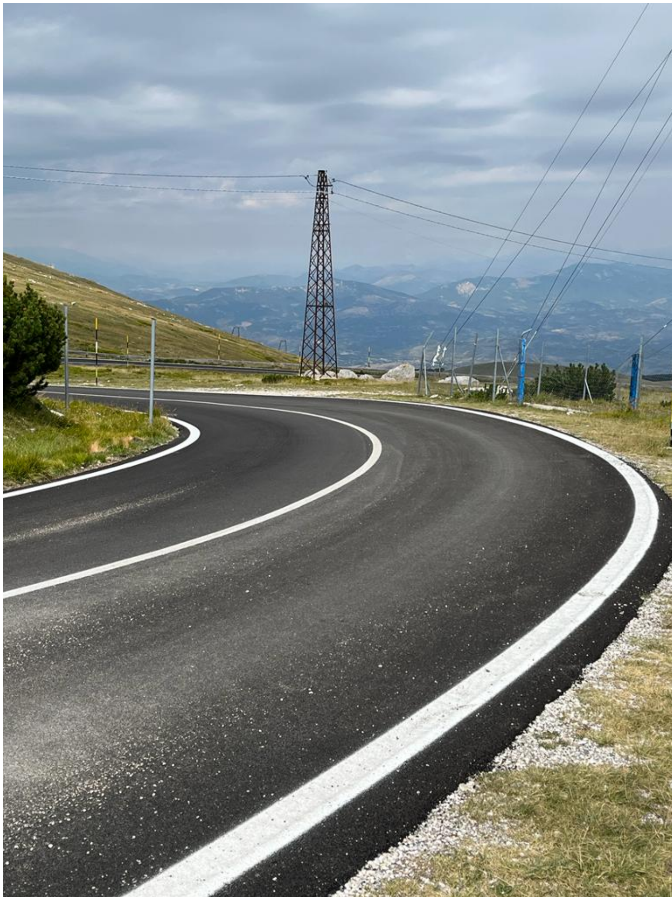
CHIETI - "Questa mattina ci siamo recati presso il Rifugio Bruno Pomilio per verificare la messa in sicurezza della strada provinciale 614 - La Maielletta, con particolare riferimento agli ultimi tre chilometri che conducono alla nota struttura
