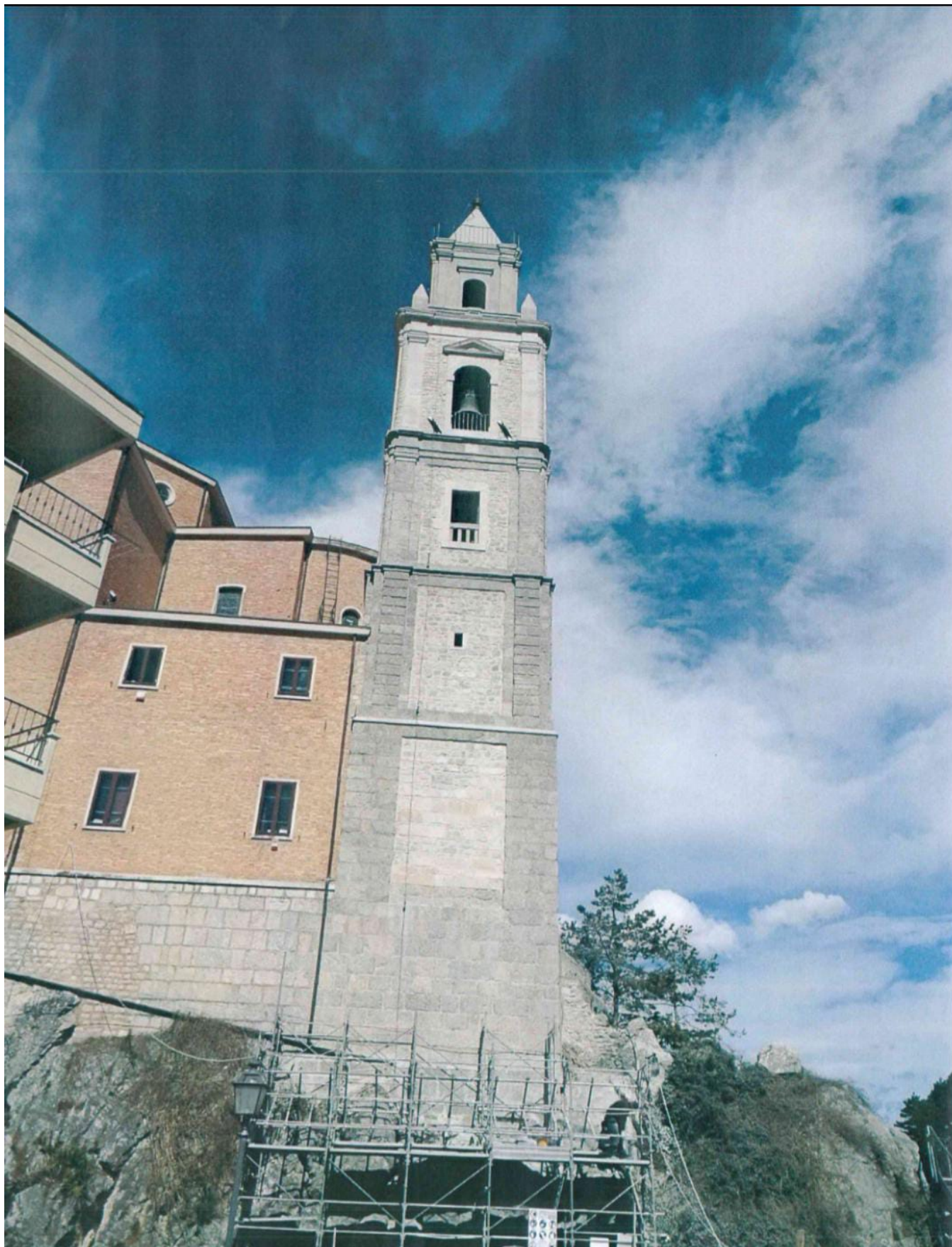
SULMONA - “Sono lieto di poter portare a conoscenza di tutti il completamento dei lavori di restauro del campanile della chiesa parrocchiale di Palena”, è quanto dichiara Mons. Fusco, vescovo di Sulmona-Valva, a seguito di un’importante opera di restauro dell’edificio sacro. “Un intervento reso possibile grazie al contributo prezioso dell’8×1000 alla Chiesa cattolica”, prosegue Fusco, “un segno tangibile di come la fede e la generosità dei fedeli si concretizzano nel sostegno al nostro
