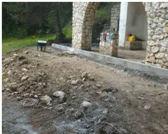
POGGIO PICENZE – “E finalmente... L’inizio dei lavori”.
