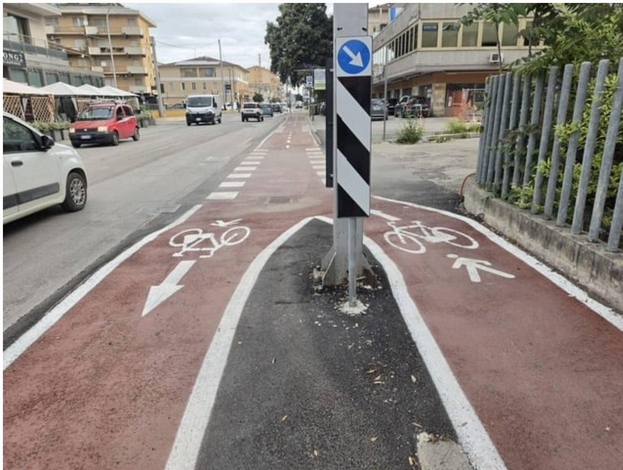
Pista ciclabile Chieti Scalo, Colantonio e Di Paolo: opera difforme dal progetto, non a norma e pericolosa
