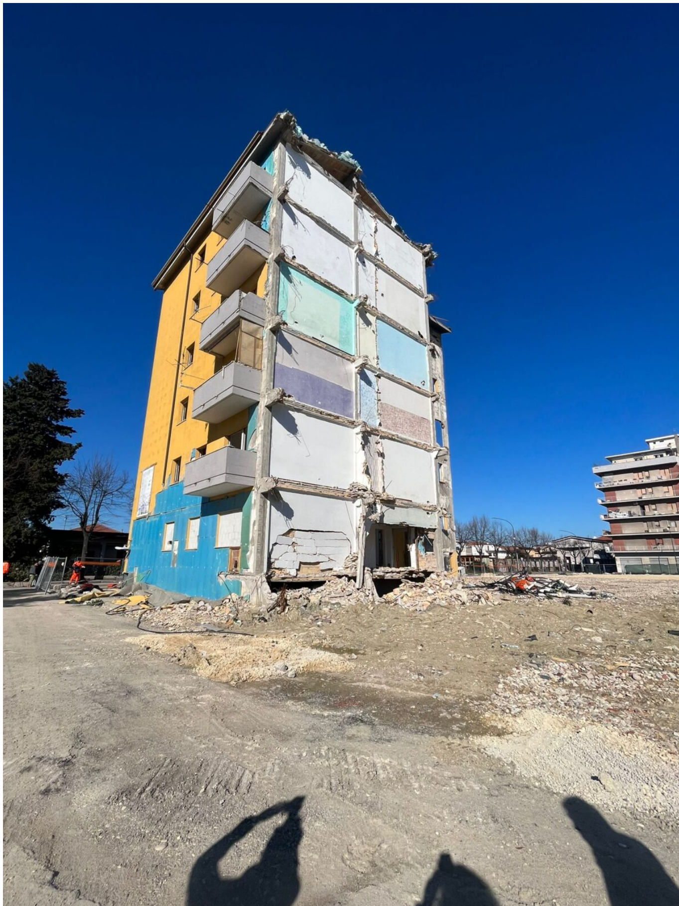
PESCARA – “Scatterà alle 8.30 di domani, martedì 30 gennaio, il primo colpo di benna per l’abbattimento dell’ultima palazzina del Ferro di Cavallo, nel rione Villa del Fuoco. Questa mattina l’impresa Gentile Ambiente, che si è aggiudicata
