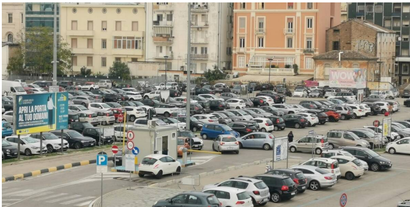
PESCARA - Lavori nell'ex area di risulta - primo lotto.
