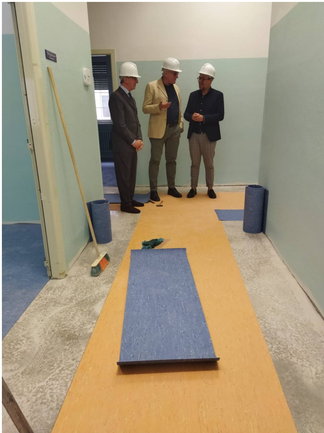
LANCIANO - La Rianimazione di Lanciano (Chieti) riapre nei tempi previsti. È quanto scaturisce dal sopralluogo compiuto sul cantiere questa mattina dal Direttore generale della Asl Thomas Schael alla presenza del Sindaco Filippo Paolini e Francesco
