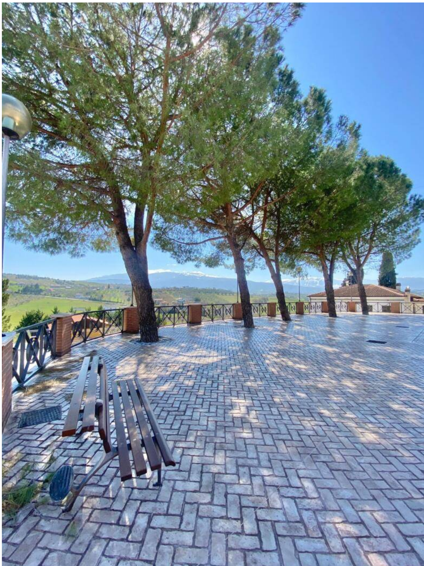
PESCARA - Una nuova pavimentazione in calcestruzzo stampato, il rifacimento dei marciapiedi perimetrali, la pulizia delle caditoie e la sistemazione degli arredi urbani.
