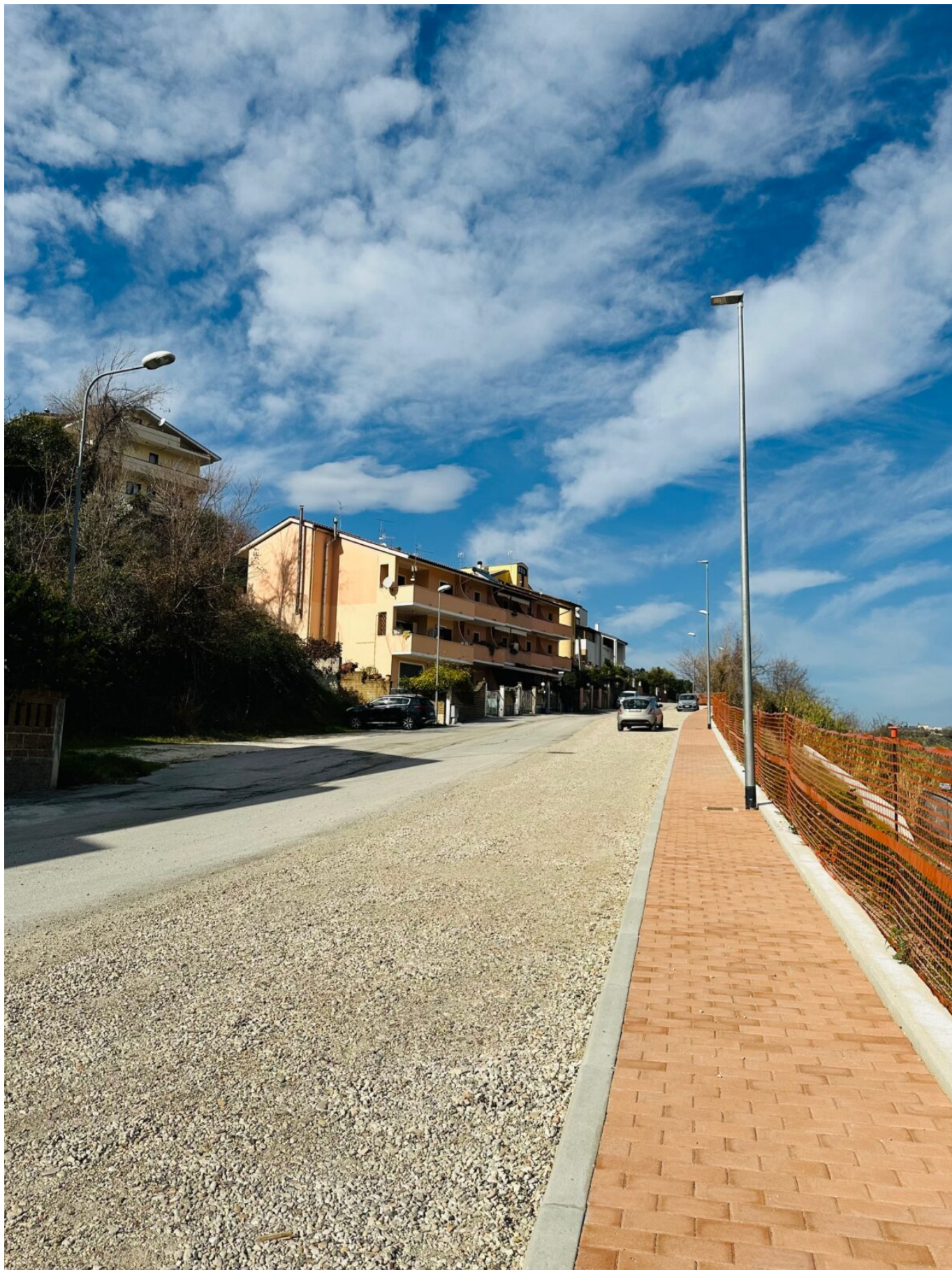
MANOPPELLO - Grazie ad un investimento del Comune che interverrà con fondi propri, per 100 mila euro di risorse, saranno completati i lavori di messa in sicurezza e consolidamento della frana di via Boccaccio a Manoppello (Pescara).
