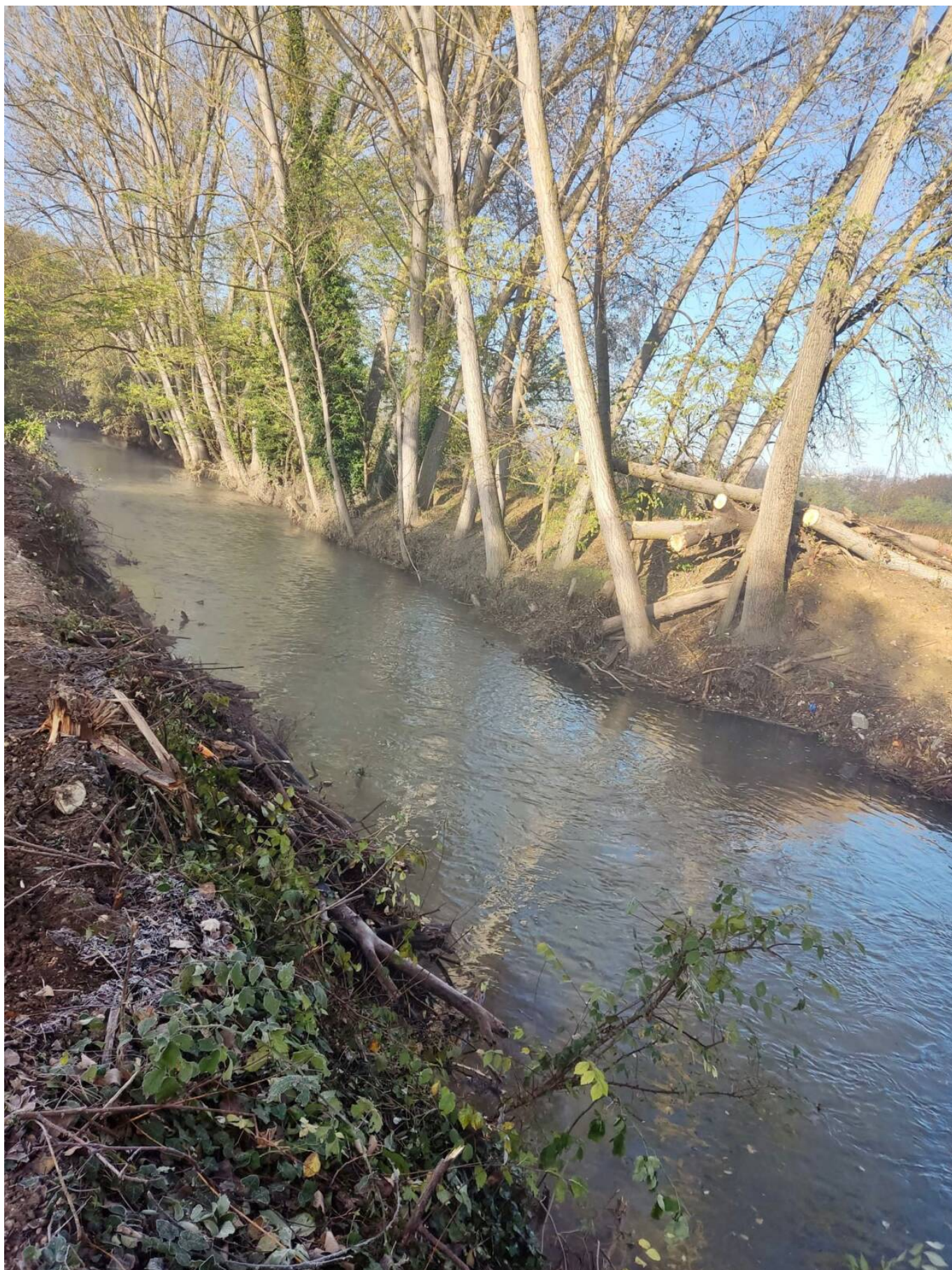
L'AQUILA - "I lavori di ripristino, messa in sicurezza e ripulitura del tratto del Fiume Aterno compreso tra Bazzano e Monticchio sono stati completati con successo". Lo annuncia in una nota il consigliere comunale della Lega aquilana
