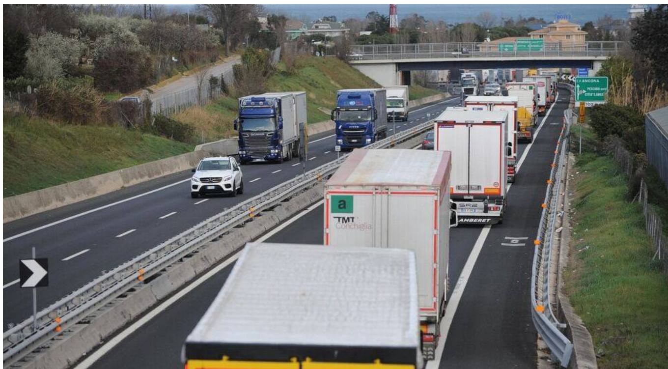
FOSSACESIA – “Tempistiche certe per i lavori sulla A14”.
