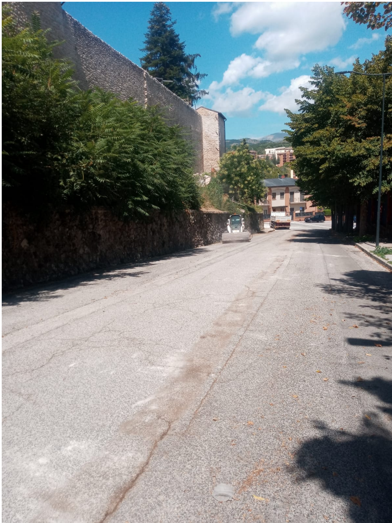
L'AQUILA - Torna percorribile Viale Ovidio, rimasto interdetto al traffico pedonale e veicolare a seguito del crollo di una parte delle mura urbane del monastero di San Basilio il 31 marzo scorso.
