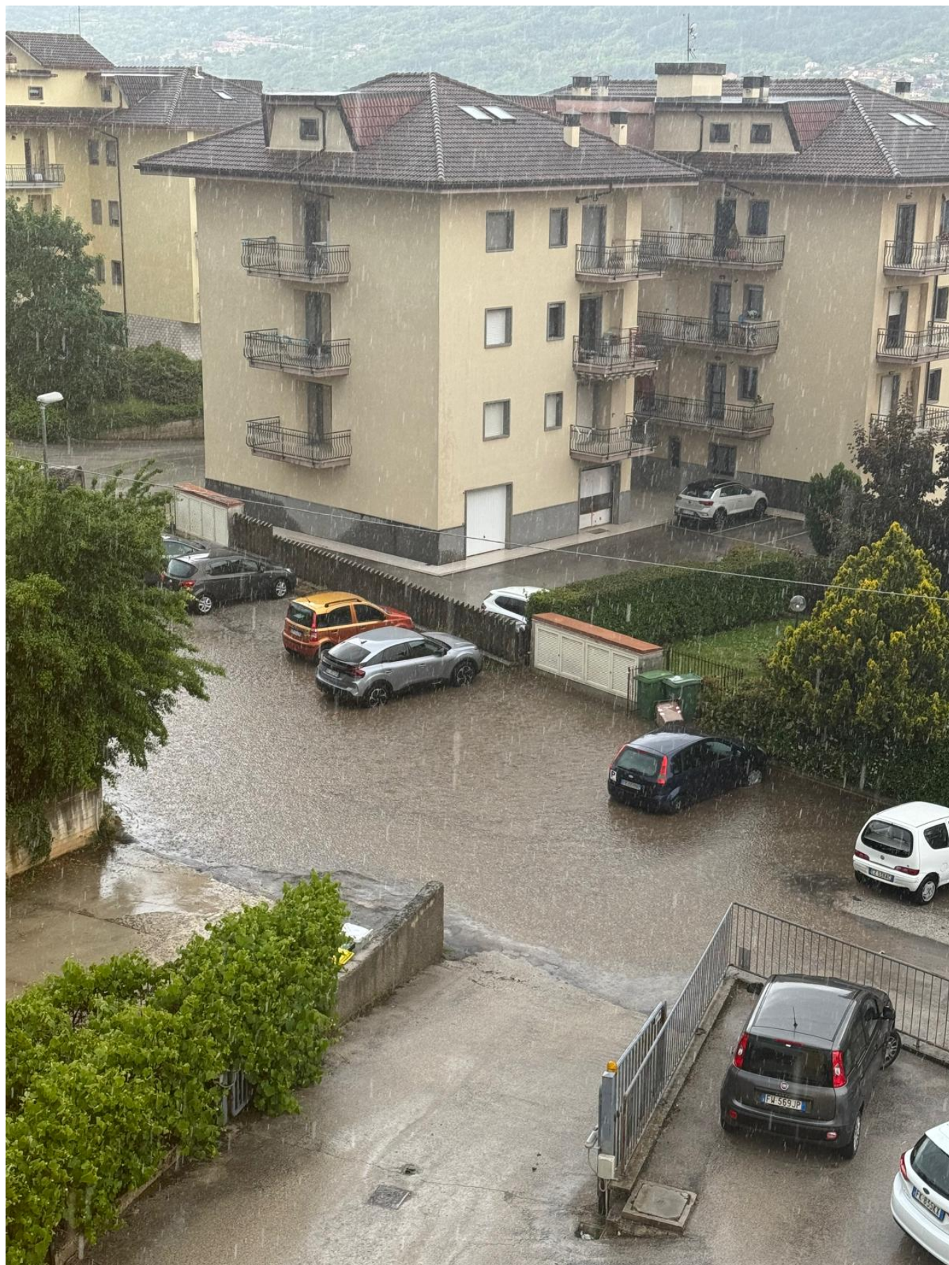
L'AQUILA- Un acquazzone durato meno di 30 minuti ha mandato in tilt la circolazione nella zona est del capoluogo di regione con strade allagate e automobili in panne.
