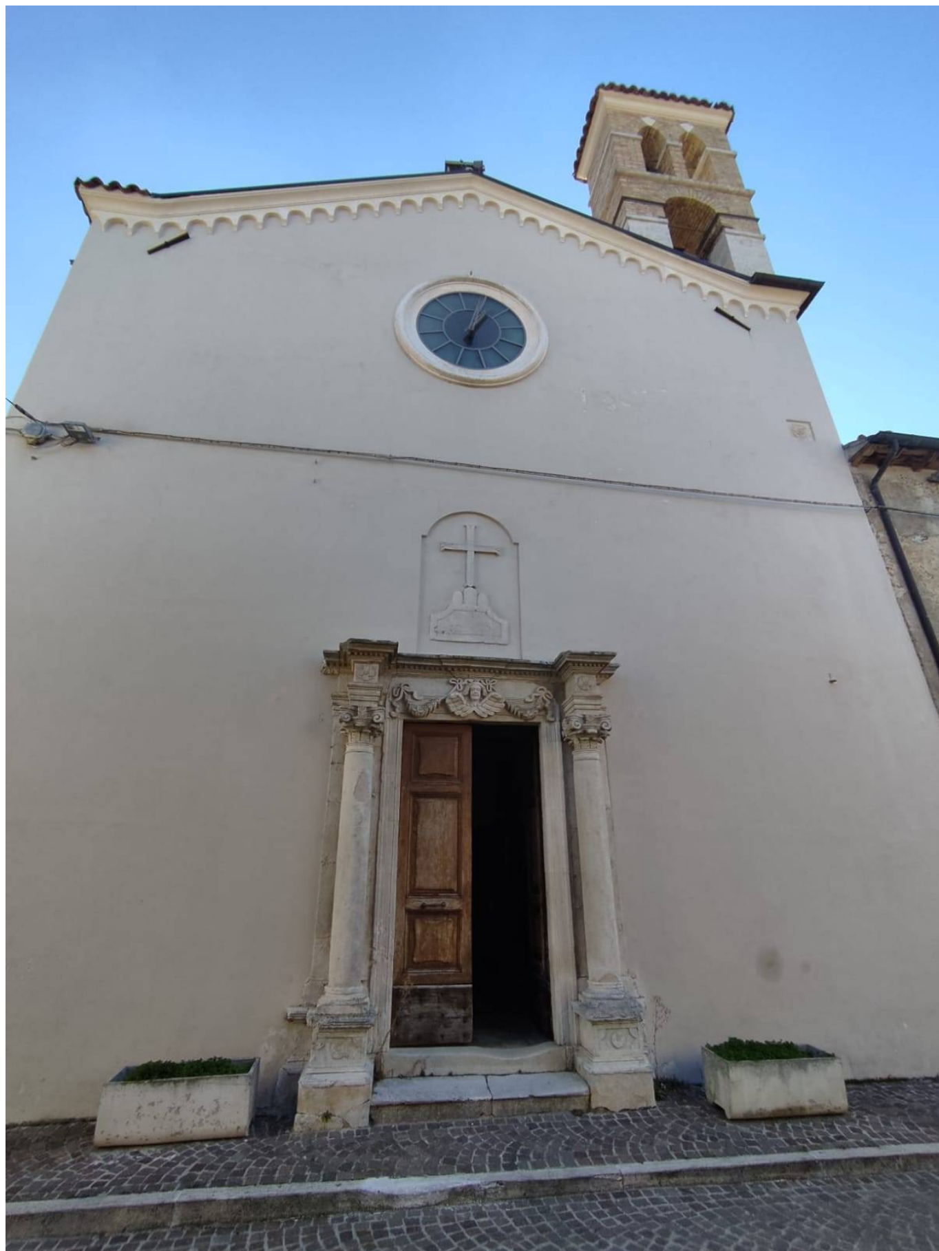
L'AQUILA - "Dopo un primo intervento parzialmente risolutivo per il recupero della struttura, si è arrivati dopo l'attento lavoro del Responsabile del Procedimento, Michele Suriani, all'affidamento della progettazione esecutiva per il restauro
