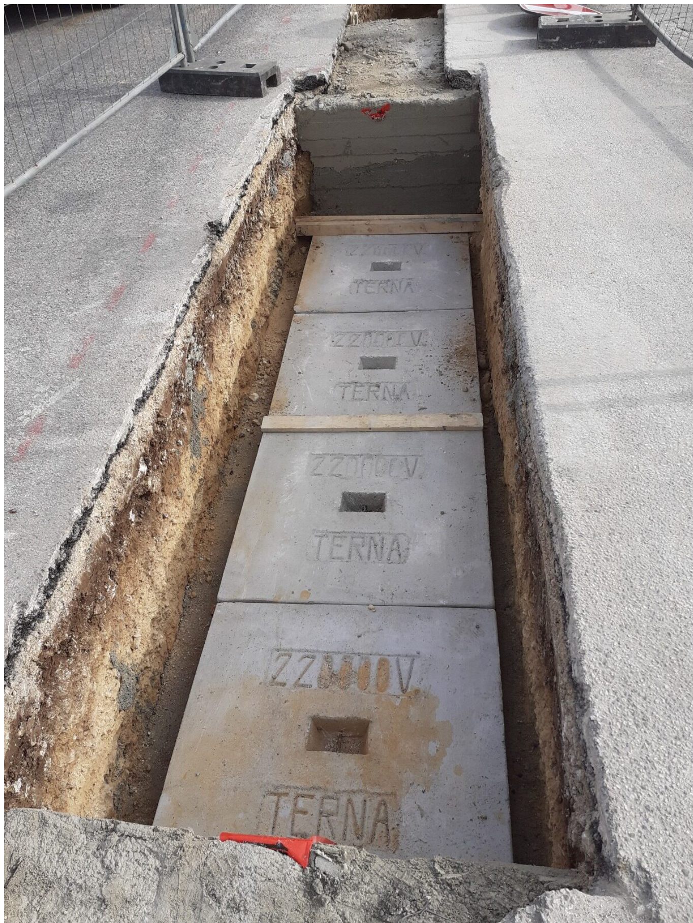
L'AQUILA - "Con il ripristino della pavimentazione stradale in corso di ultimazione sono da considerarsi sostanzialmente terminati i lavori per l'interramento dell'elettrodotto Terna tra la stazione elettrica di Pettino e la Cabina primaria del
