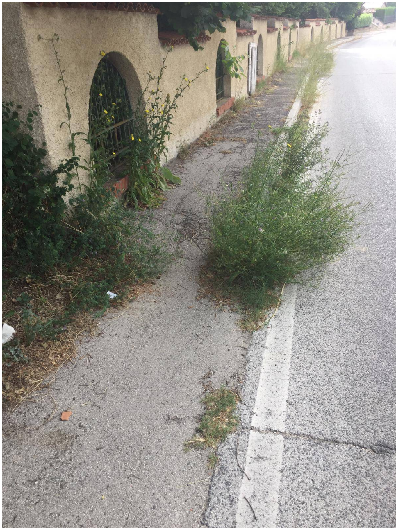
L'AQUILA - Continuano le segnalazioni sullo stato di incuria dei marciapiedi dell'Aquila, abbandonati e invasi dalla vegetazione.
