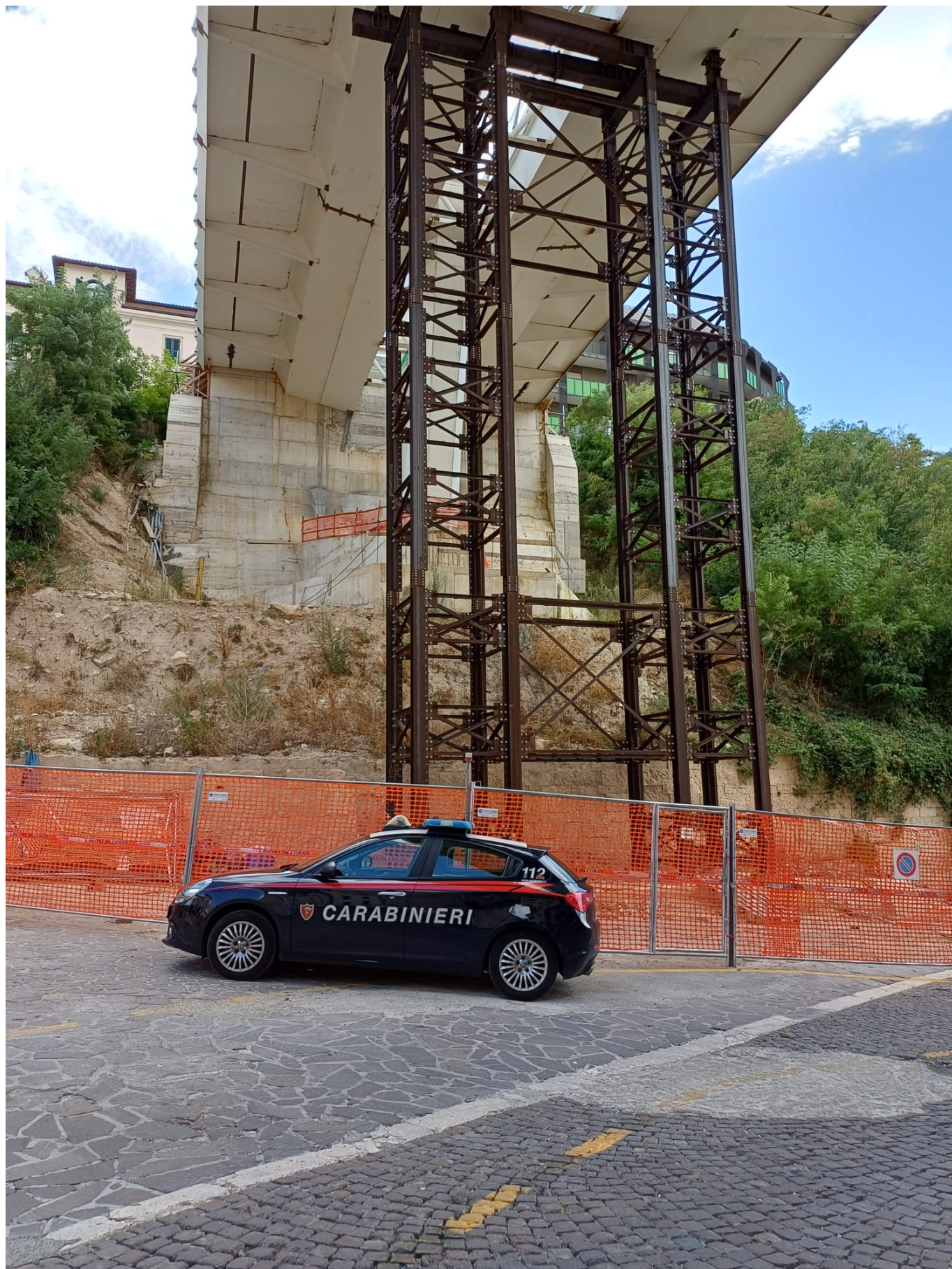
L'AQUILA - Topi di appartamento a segno nelle abitazioni di via Fontesecco 29, sotto il ponte di Belvedere ora in fase di ultimazione dei lavori, all'Aquila: si tratta di case tuttora disabitate dopo la ben nota ordinanza sindacale che ne vieta l'uso
