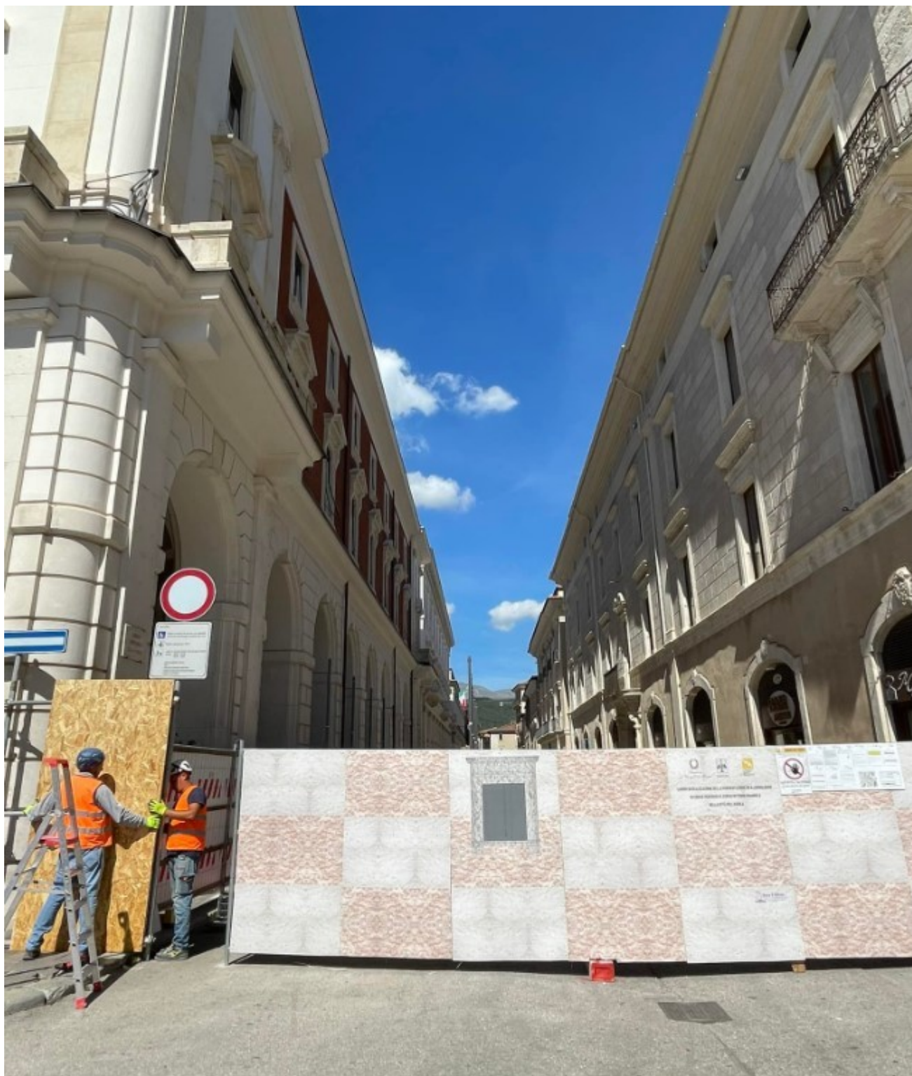
L'AQUILA - Iniziati ieri, procedono i lavori della ripavimentazione del centro storico dell'Aquila, lungo corso Vittorio Emanuele
