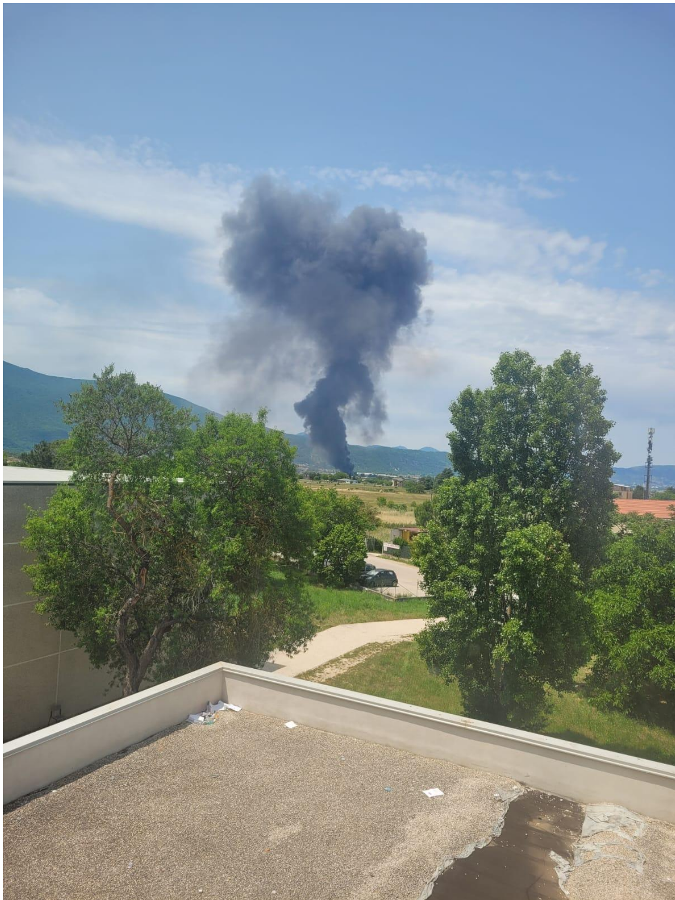
LUCO DEI MARSI - A fuoco nella tarda mattinata di ieri lo stabilimento della Cooperativa PAF (Produttori Agricoli del Fucino), lungo Strada 43 a Luco dei Marsi (L'Aquila). Le fiamme, sono forse partite dalle celle frigorifere dell'impianto intorno alle
