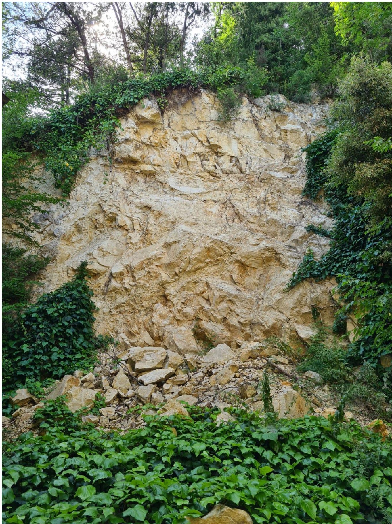
GUARDIAGRELE – Il Comune di Guardiagrele (Chieti) ha consegnato i lavori di messa in sicurezza del costone roccioso situato in località Bocca di Valle, un intervento reso necessario a seguito degli eventi metereologici del 2023 che costrinsero
