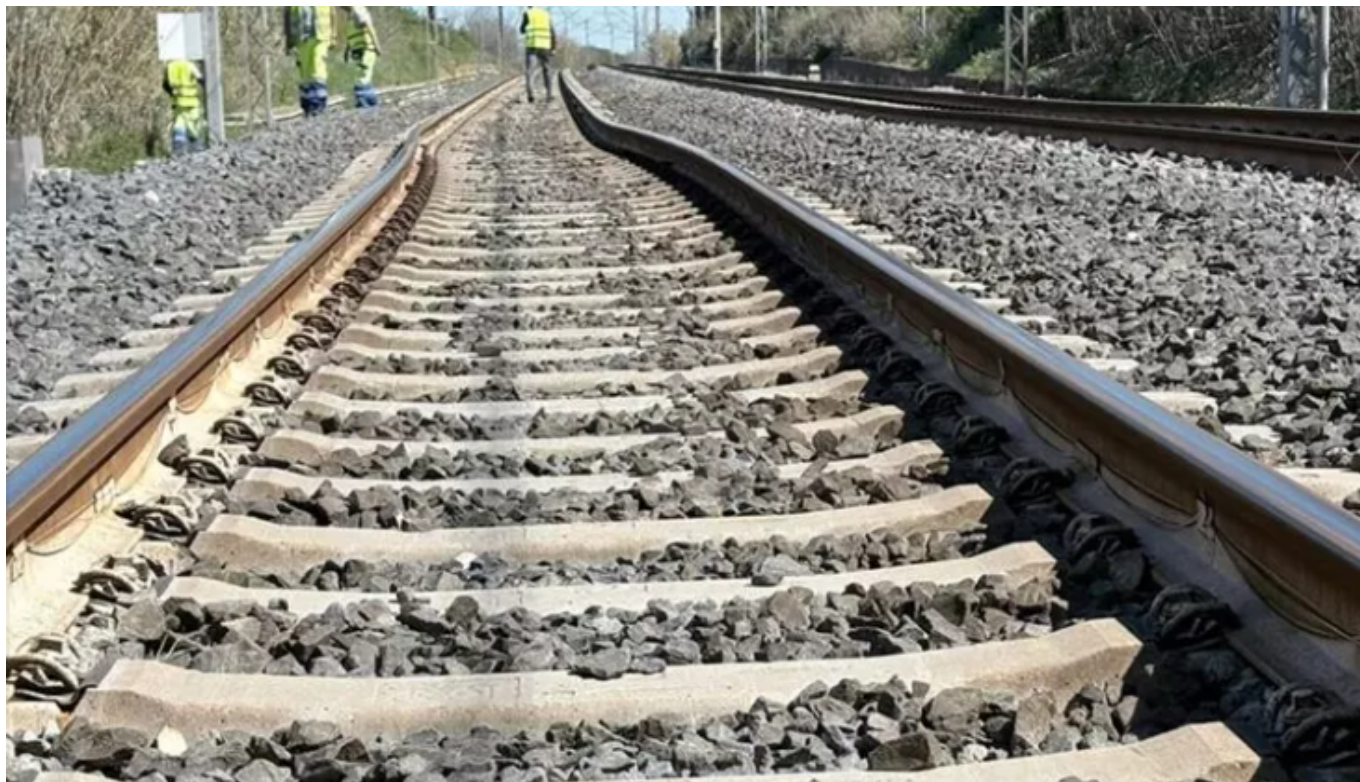
PESCARA - Binari deformati di una decina di centimetri.
