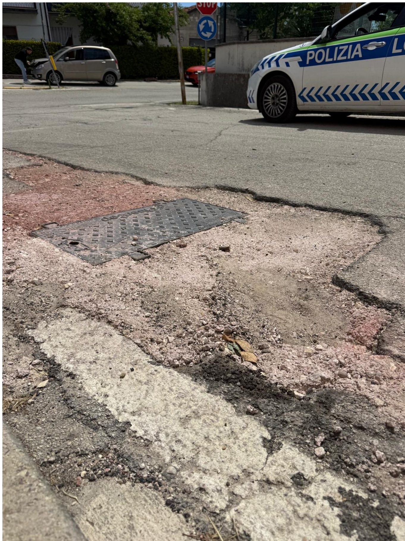
FOSSACESIA - Continua senza sosta a Fossacesia (Chieti) l'attività di vigilanza e controllo della Polizia Locale sui lavori eseguiti sulle strade comunali da enti pubblici, società concessionarie di servizi e soggetti privati. Un'azione costante
