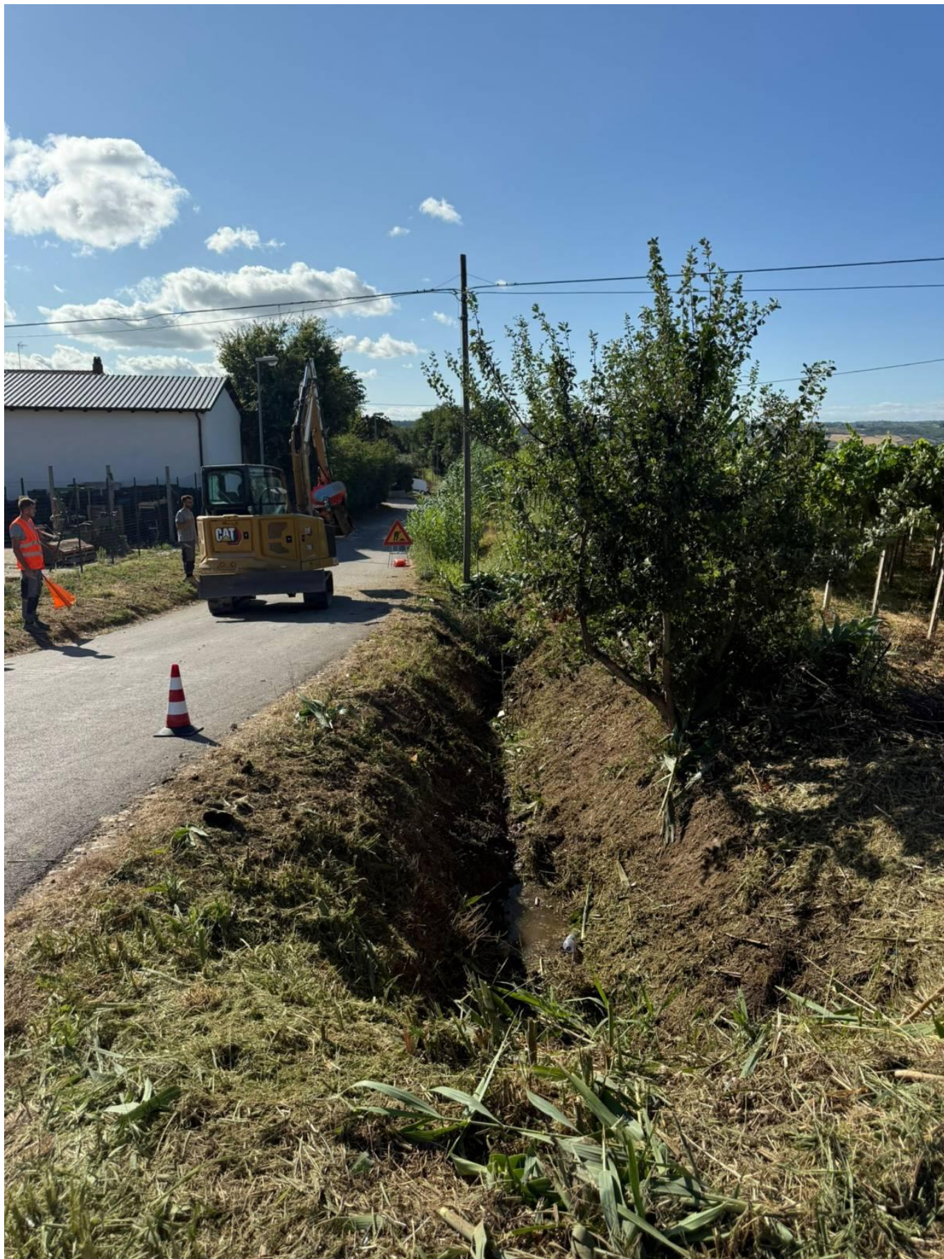
FOSSACESIA – Sono partiti nei giorni scorsi, da Via Fonticelli, i lavori del progetto di messa in sicurezza idraulica del territorio comunale di Fossacesia (Chieti), finanziato con un investimento di 1.284.000 euro grazie a fondi del Ministero dell'Interno in
