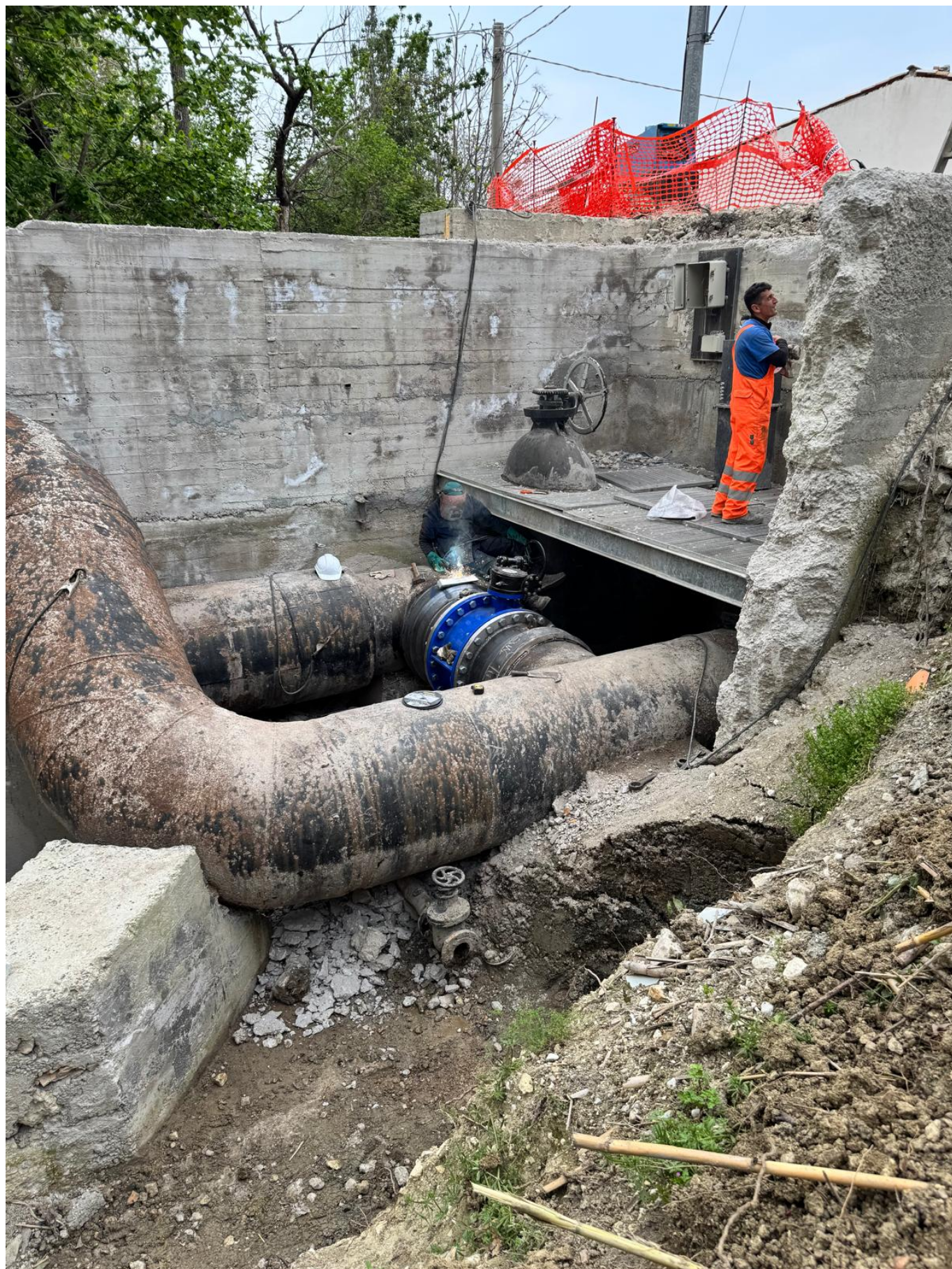
PESCARA – Proseguono regolarmente, nel rispetto dei tempi previsti, i lavori di manutenzione straordinaria sulla rete idrica gestita da Aca sull'acquedotto Giardino.
