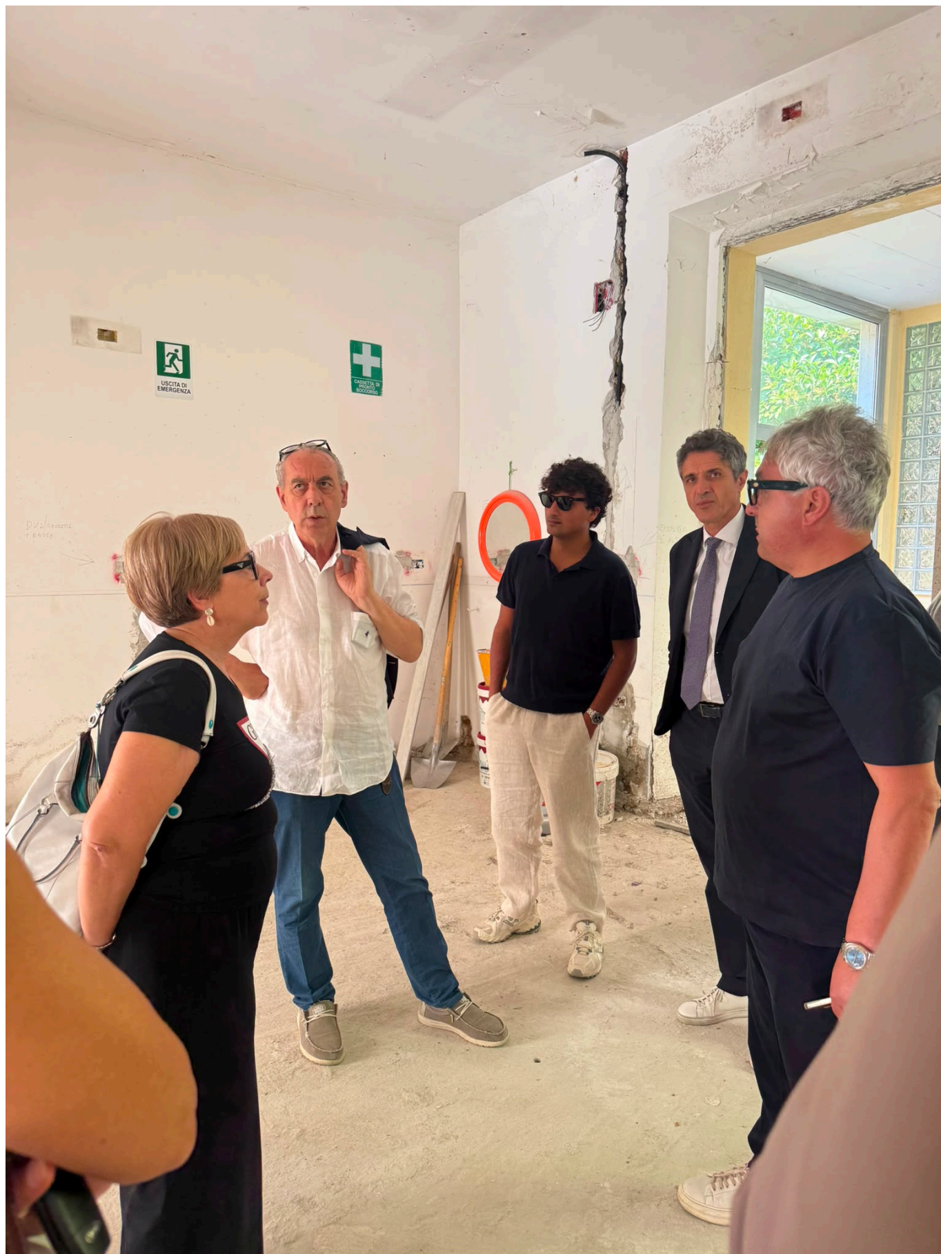
CHIETI - Nuovo sopralluogo questa mattina del sindaco Giovanni Legnini in altri tre dei principali cantieri cittadini finanziati con risorse del PNRR, insieme all'assessore ai Lavori Pubblici Luigi Febo, al dirigente e alla funzionaria del Settore Tecnico
