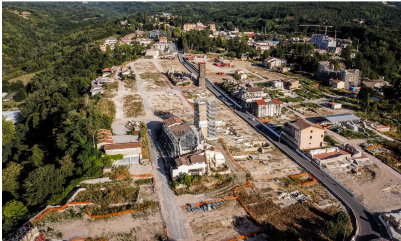
AMATRICE – “Un cantiere, finalmente in movimento”.
